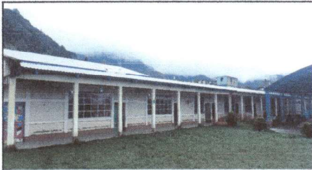
Foto1: sustitucion de lámina
