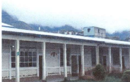
Foto 3: sustitucion de lámina
