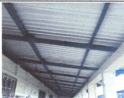
Foto 2: sustitucion de lámina
