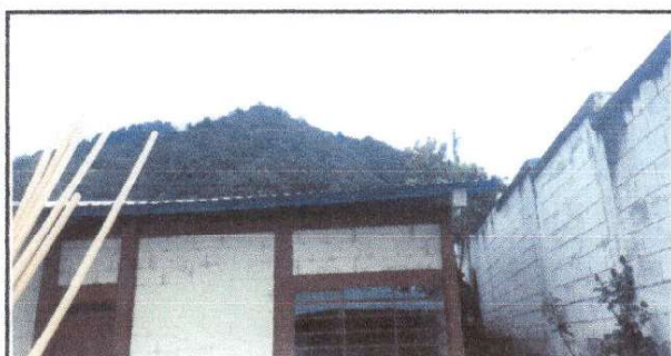
Foto 5: sustitucion de lámina cocina
