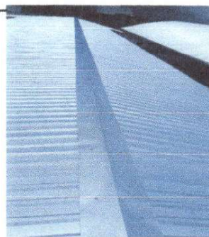
Foto 6: sustitucion de capote
